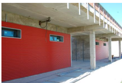
Chapa acero -Universitat Sant Jaume (Castellón)
